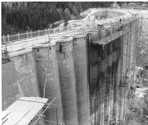
Bild 2. Instandsetzung der undichten Staumauer mit einer flächendeckenden, zweischaligen bewehrten Spritzbetonschicht und einer abschliessenden PVC-Dichtungsplane mit Abdeckung aus nichtrostendem Stahl.
