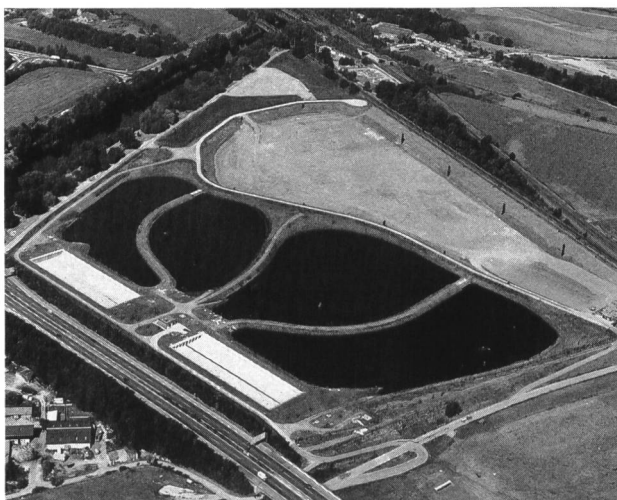
Bild 4. Luftbild Klärwerk Duisburg-Kasslerfeld: Filterkuchendepotie und Regenwasserbehandlung auf der Ruhrinsel Raffelberg.
