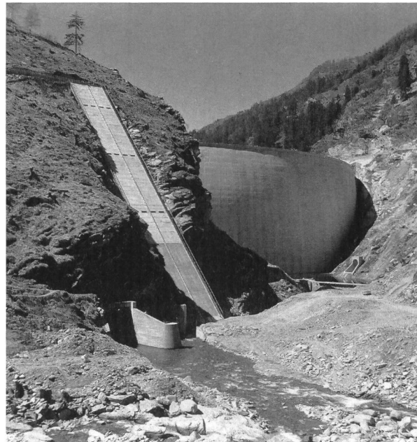
Bild 1. Stauanlage am Ende der Bauarbeiten im Jahre 1959.
