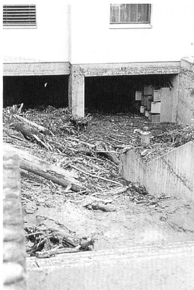
Bild 7. Der Hauseingang befindet sich im Untergeschoss und wird, auch bei geringer Überschwemmungstiefe, zur Fluchtfalle. (Foto: Th. Egli)
