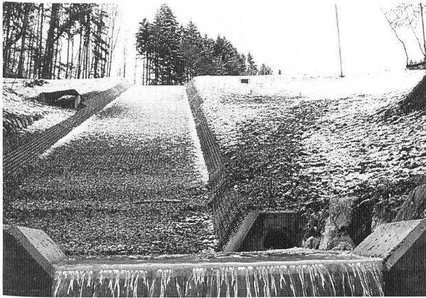
Bild 2. Hochwasserentlastungsrinne nach Fertigstellung im Spätherbst 1991.
