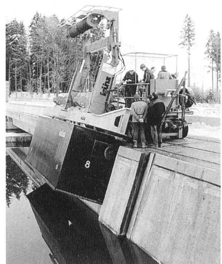
Bild 2, rechts, zeigt den Krane beim Einsetzen eines Dammbalkens.
