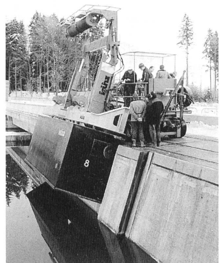
Bild 2, rechts, zeigt den Krane beim Einsetzen eines Dammbalkens.
