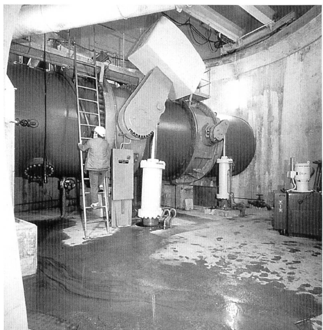
Bild 1. Wasserschloss: Nicht nur hier sind Funktionsstörungen durch Kondenswasser und Korrosion möglich.
