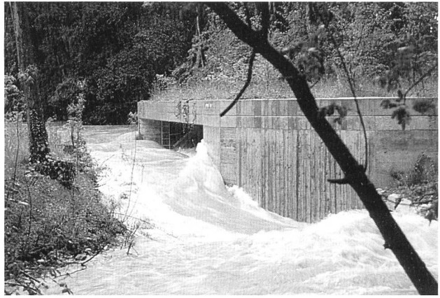
Bild 8. Das Einlaufbauwerk Niederlenz während eines Hochwassers am 19. Mai 1994: Vom Aabachzufluss ( Q = 20 \text{ m}^3/\text{s} ) werden ca. 7 \text{ m}^3/\text{s} über das Streichwehr entlastet.
