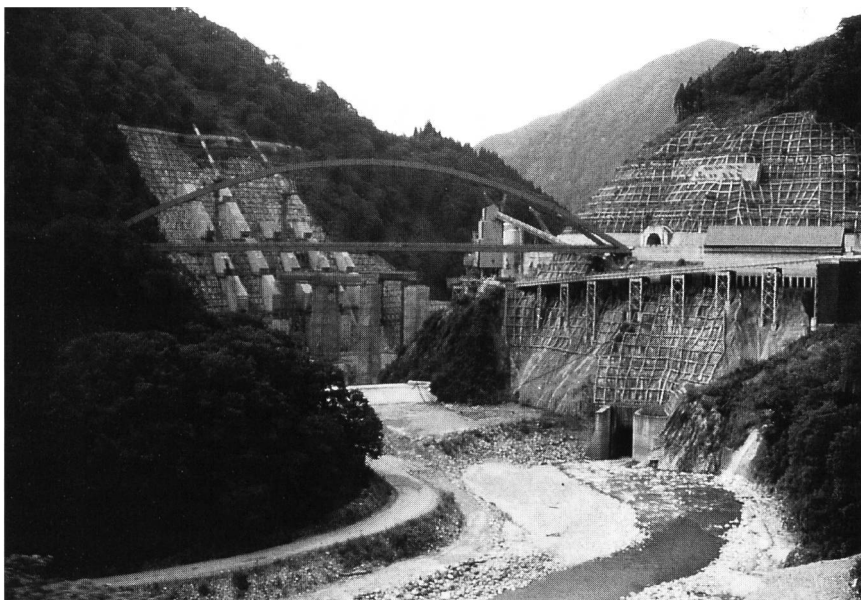
Figure 2. Vue vers l'amont du barrage de Dashidaira. Les évacuateurs de crues, les deux pertuis de purge et l'ouvrage de restitution du débit de dotation sont visibles (Photo F. Raemy).
