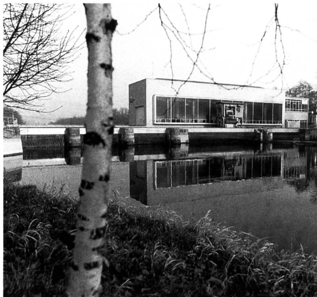
Bild 3. Das Kraftwerk Ruchli-Aarau mit Krafthaus und Rechenreinigungsanlage.
