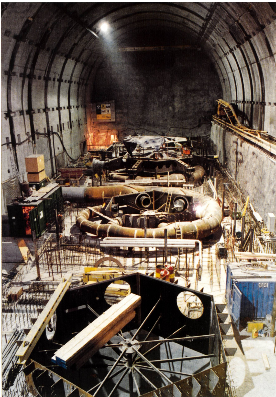
Montage der vier Maschinengruppen in der Kavernenzentrale Amsteg.
