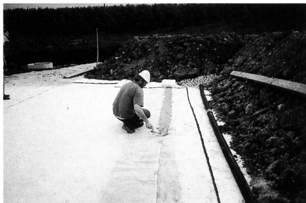
Bild 2. Kantenabspachtelung der Dichtungsmatte Bentofix D 4000.
