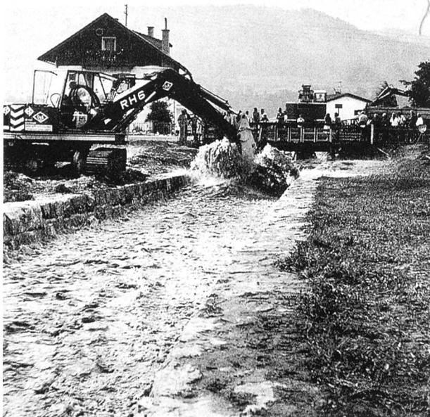
Bild 1. Volderbach bei Hochwasser mit stehenden Wellen, die das Freibord verringern (Bild: H. Lang).
