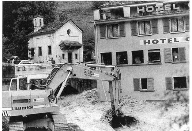
Bild 3. 1994er Hochwasser am Chrumbach/Simplon. Zwei Bagger halten den Brückendurchlass bei Gabi frei (Bild: J. Escher).
