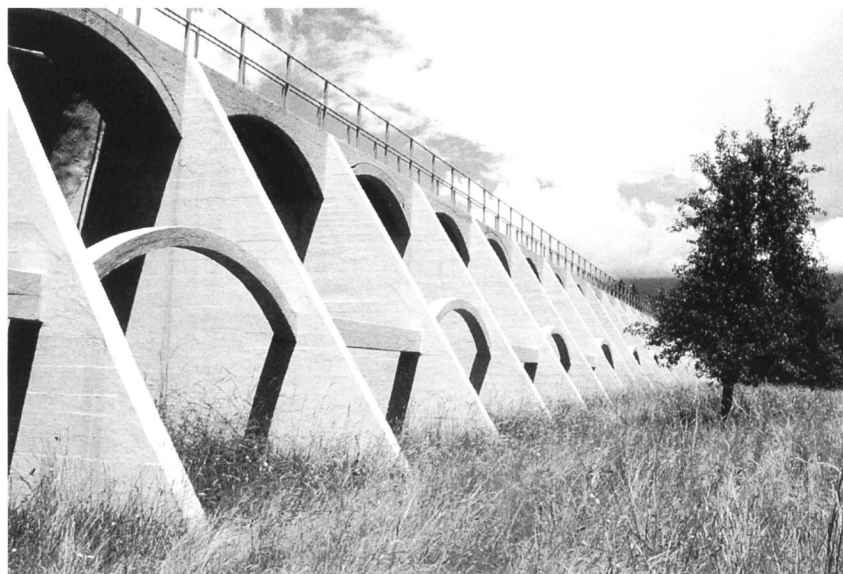
Figure 1. Vue du barrage des Marécottes depuis l'aval.
