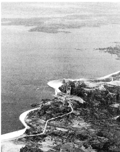
Bild 1, links. Almendra 1970. Die Bogensperre ist 202 m hoch und zusammen mit den Anschlussbauwerken 567 m lang. Vom grossen Stausee führt ein 15 km langer Druckstollen zu den Pumpenturbinen im unterirdischen Kraftwerk Villarino am Duero.
