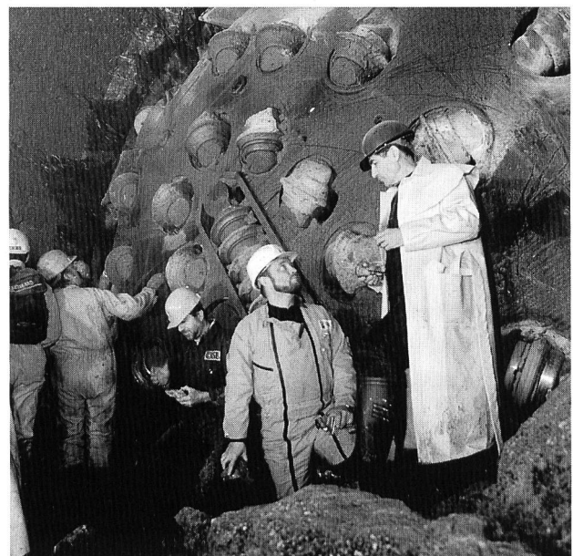
Figure 1. Cleuson-Dixence, Tortin, tête de tunnelier (photo: Preisig 18 septembre 1996).
