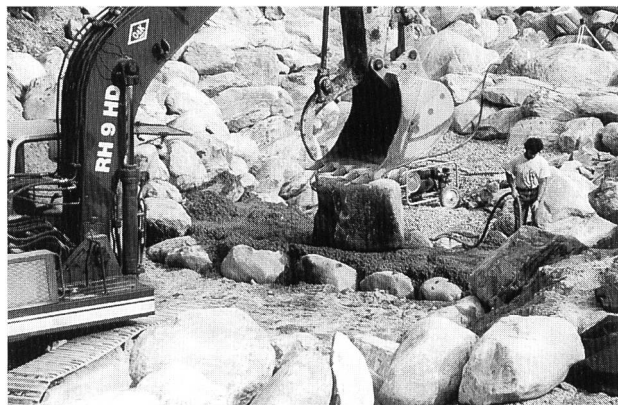
Bild 4 (August 1995). Gerinnesicherungsarbeiten im Schüttbereich, hier am Fusse der Steilstrecke. Das verwendete Schüttmaterial bestand aus gefrästem Vereina-Tunnelausbruch und wies ein Maximalkorn von lediglich etwa 15 mm auf.
