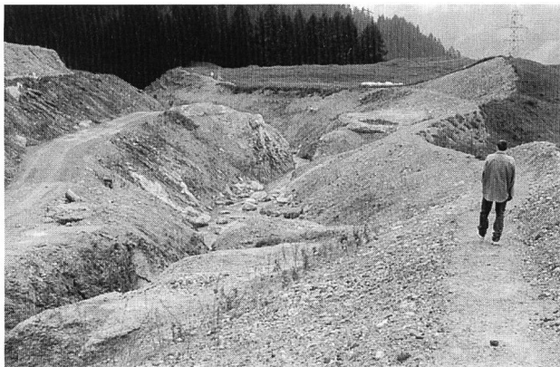
Bild 3 (Mai 1998). Das neugestaltete Stützbachgerinne windet sich heute in einem 10 bis 20 m tiefen Einschnitt durch das Selfranga-Plateau. Links die noch zu «kaschierende» Baupiste, rechts der neu angelegte «Schluchtweg» als beliebte Wanderwegverbindung zwischen Davos und Klosters.
