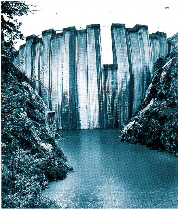
Figure 10. Le barrage-voûte de Contra de la Verzasca SA, construit 1961 à 1965 (Photo: J. Mulhauser, Fribourg, du 17 septembre 1964).
