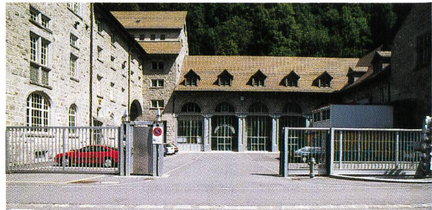
Bild 37. Kavernen-Hauptzugang in der Hoffassade des Werkstattgebäudes.
