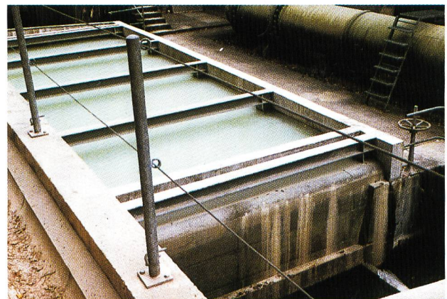
Bild 34. Bevor das Baustellenwasser in den Vorfluter zurückfliesst, wird es hinter der jetzigen Kavernenzentrale in einer eigens eingerichteten Anlage neutralisiert.
