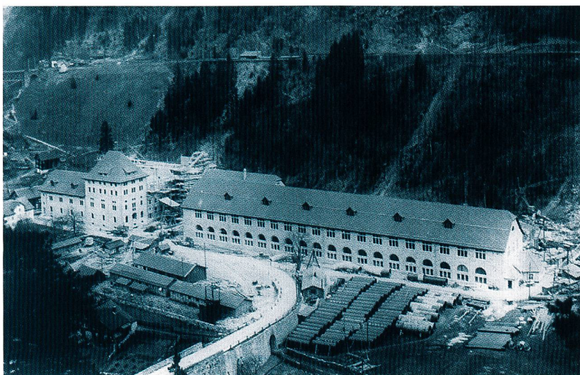
Bild 4, links. Das Kraftwerkgebäude während der Bauzeit (26. März 1921). Rechts neben der Plattbrücke sind die Rohrschüsse für die Druckleitung gelagert.
