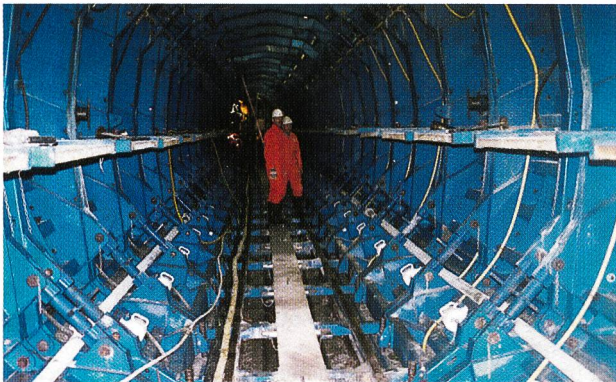
Bild 15. Betonschalung im neuen Druckstollen. Die Betonieretappen waren 48 m lang; der Betonierfortschritt ging mit dem Wasserlauf (Foto J. Dittli vom 4. Februar 1997).
