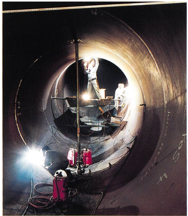
Bild 17. Schweissarbeiten im Druckschachtfuss (Foto P. Mainardi vom 23. August 1995).
