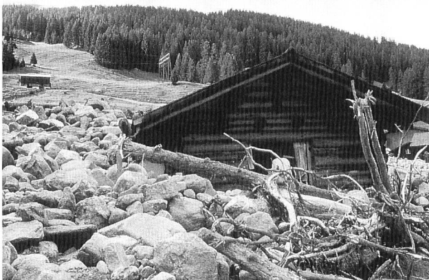
Bild 4. Davos-Glaris GR, 15. August 1998. Ein durch die Geschiebeausbrüche des Chummerbaches beschädigtes Gebäude im Kegelbereich. Insgesamt lagerte der Bach rund 50 000 m 3 Material ab (Foto: C. Hegg, WSL).
