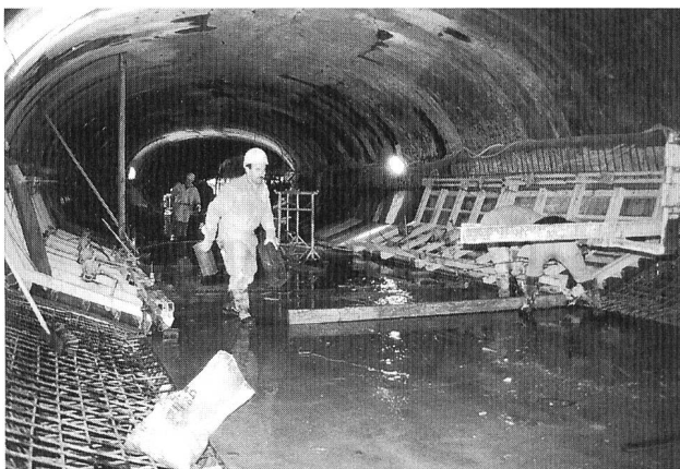
Bild 2. Betonieren der UW-seitigen Stollensohle mit Konterschaltung.
