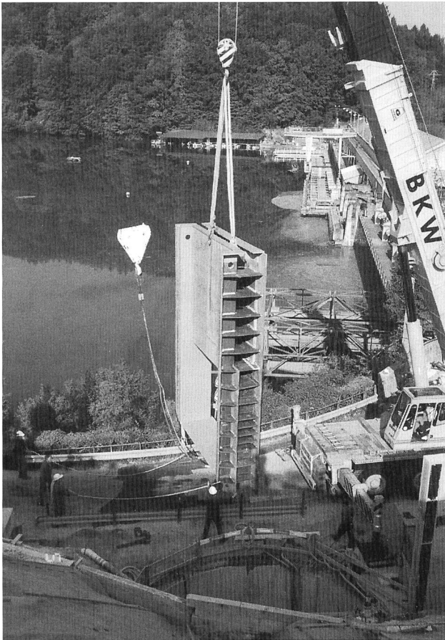
Bild 4. Ein Schützengehäuse bereit zum Absenken. Im Vordergrund ist der Schützenschacht zu erkennen. Hinter dem BKW-Kran sind das Wehr und das Maschinenhaus zu sehen.
