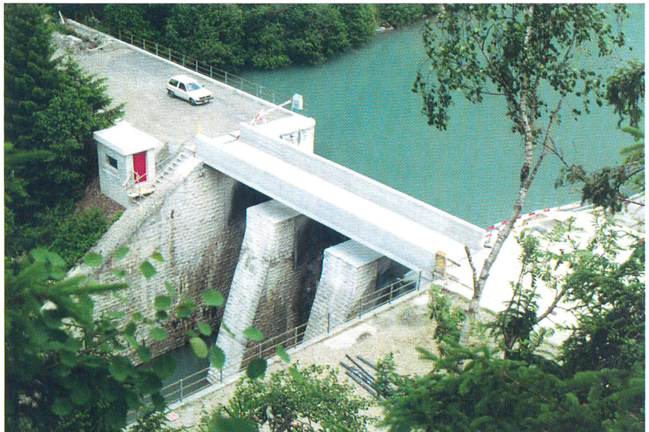
Bild 11. Übersicht aus der Vogelperspektive auf die umgebaute Wehranlage. Auf dem rechten Widerlager ist talseitig der Zugang zu den Antriebsorganen sichtbar.
