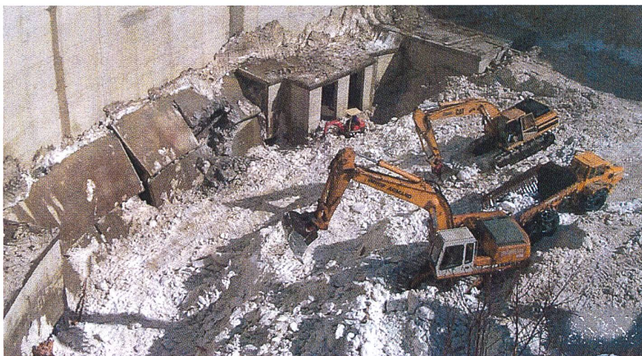
Bild 4. Freigelegte und stark beschädigte Bedienungsgalerie. Die Bedienungsgebäude der Grundablassschützen und der Triebwasserfassung sind im oberen Teil des Bildes zu erkennen (Stand 12. März 1999).
