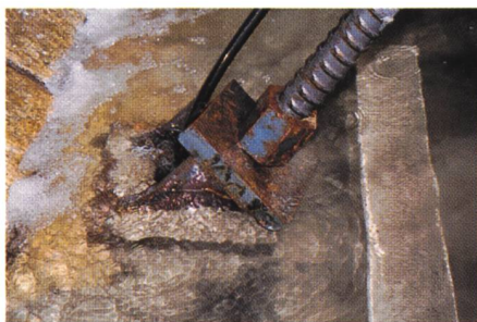
Bild 7. Pfahlschuh (unter Wasser versetzt) nach Entleerung.
