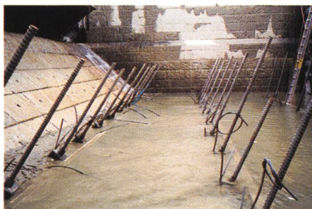
Bild 8. Mikropfähle in Sohle nach Entleerung.
