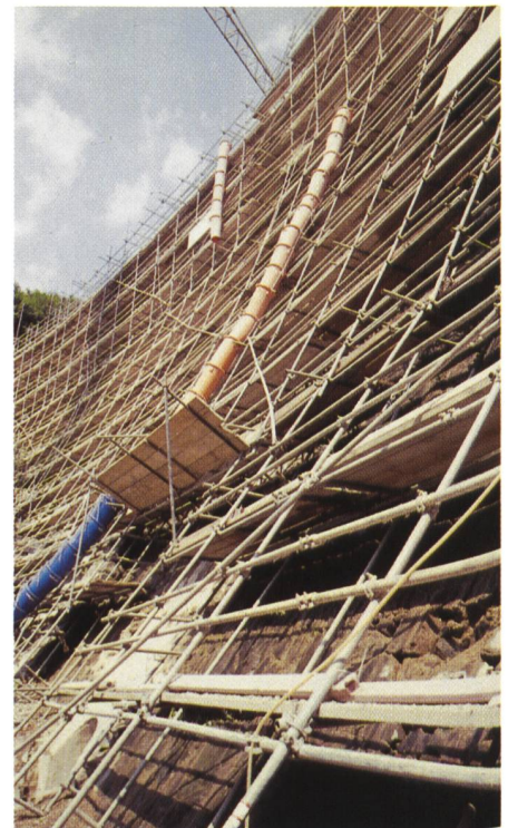
Bild 2. Detailaufnahme der Gerüstung auf der Luftseite.
