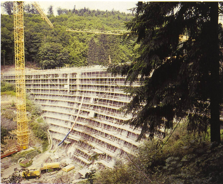
Bild 1. Instandsetzungsarbeiten an der Talsperre Neustadt: Das RUX-Rohr-Kupplungs-Gerüst folgt den Krümmungen der denkmalgeschützten Bruchsteinmauer.
