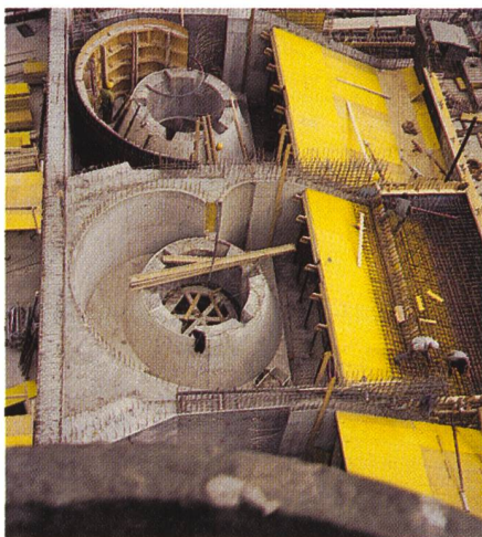
Bild 5. Einlaufspiralen.
