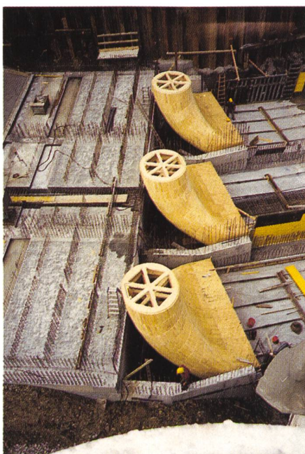
Bild 6. Saugrohrschalungen.
