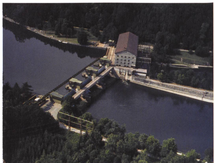
Bild 3. Kraftwerk Rapperswil-Auenstein: Stauwehr und Maschinenhaus.
