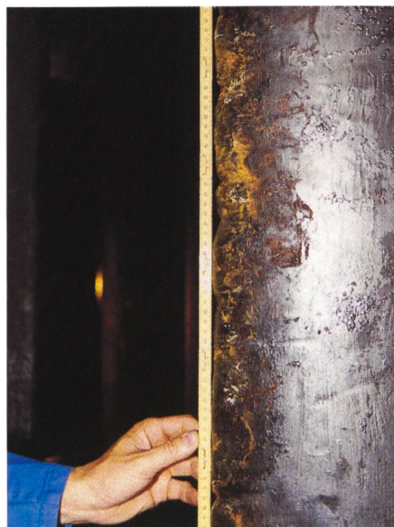
Bild 5. Kraftwerk Wildegg-Brugg: Stüttschaufel der Turbine 2 vor der Revision.
