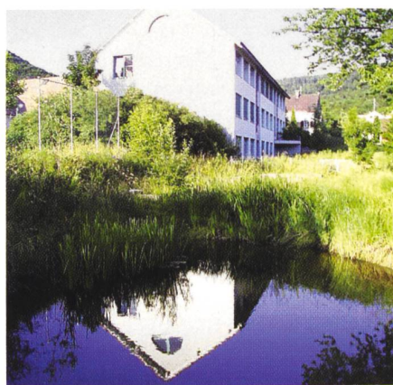
Bild 2. Regenwasserentsorgung beim Schulhaus Hohmatt: Das Regenwasser fliesst in ein naturnahes Rückhaltebecken und danach in einen Teich.
