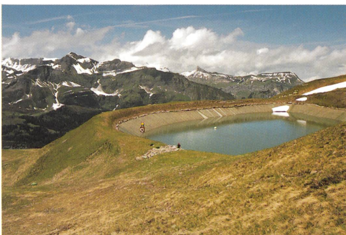
Bild 3. Speicherbecken der Beschneiungsanlage am Lauberhorn BE. Abdichtung der wasserseitigen Böschung mit einer Geomembrane (Foto: A. Kobelt).
