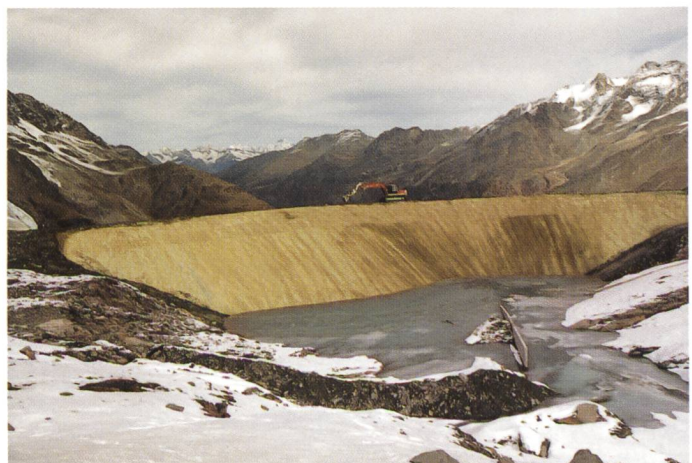
Bild 5. Abdichtung der wasserseitigen Dammböschung mit stabilisierter Bodenmischung beim Speicherbecken der Beschneiungsanlage am Othmarhang bei Saas Fee VS (Foto: A. Kobelt).
