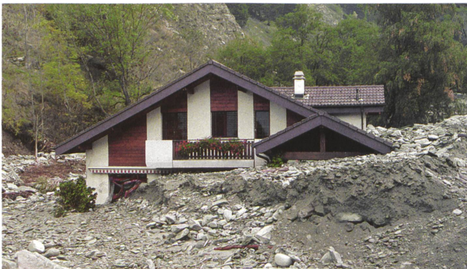
Bild 5. Zu den finanziell schwersten Schäden im Kanton Wallis kam es während des Oktober-Hochwassers in der Gemeinde Baltschieder. Gesamthaft lagerte der Hochwasser führende Baltschiederbach 150 000 bis 200 000 m 3 Material im Dorfbereich ab.
