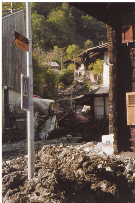
Bild 6. Ein Murgang aus dem Dorfbach verursachte in Mörel schwere Schäden im Bereich der Kantonsstrasse. Das Ereignis forderte einen Verletzten, zerstörte ein Wohnhaus sowie fünf weitere Gebäude und beschädigte die Infrastruktur des Dorfes.
