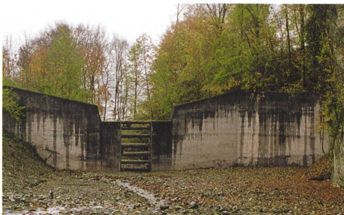
Bild 1. Balkensperre als Abschlussbauwerk des Geschiebesammlers am Sigetsbach in Sachseln OW.
