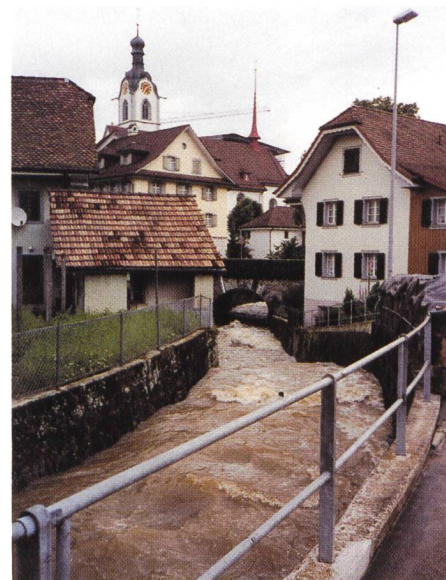
Bild 11. Durchgang der Wyna durch Bero Münster, Hochwasser vom 6. Juli 1997.
