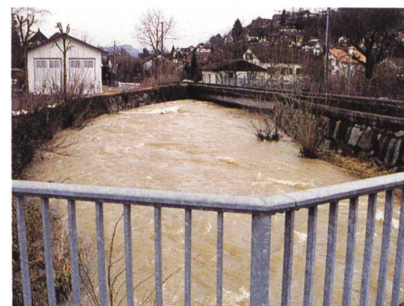
Bild 13. Blick auf die Brücke der Wynental-Suhrental-Bahn im Leerber in Gränichen.
