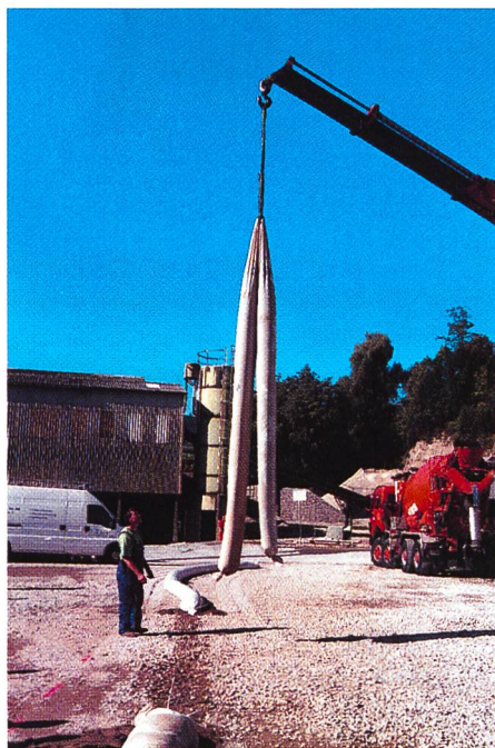
Bild 1. Verlegung von Quick-Snake.
