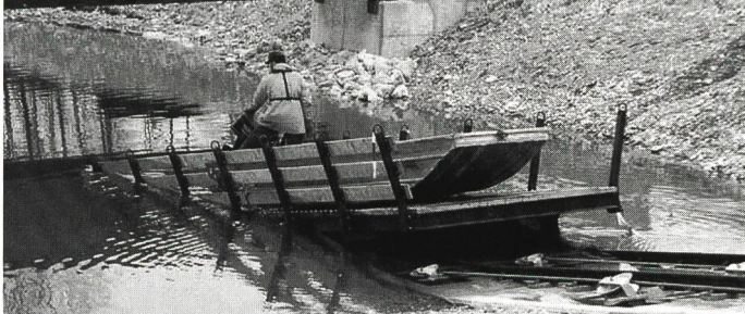
Boottransportanlage Flusskraftwerk Ruppoldingen
