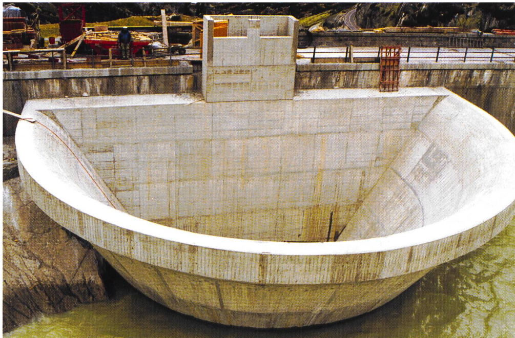
Umbau der Hochwasserentlastungsanlage Räterichsboden der KW Oberhasli
