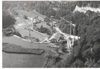
Barrage de la Maigrauge
