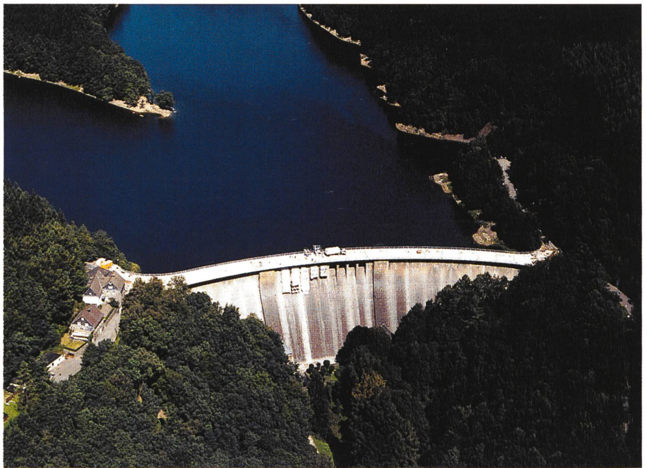
Bild 1. Auf ganzer Länge erneuerte Staumauerkrone der Aggertalsperre und die neun sanierten Überlaufbereiche in Staumauermitte. (Foto: Peiniger RöRo)
