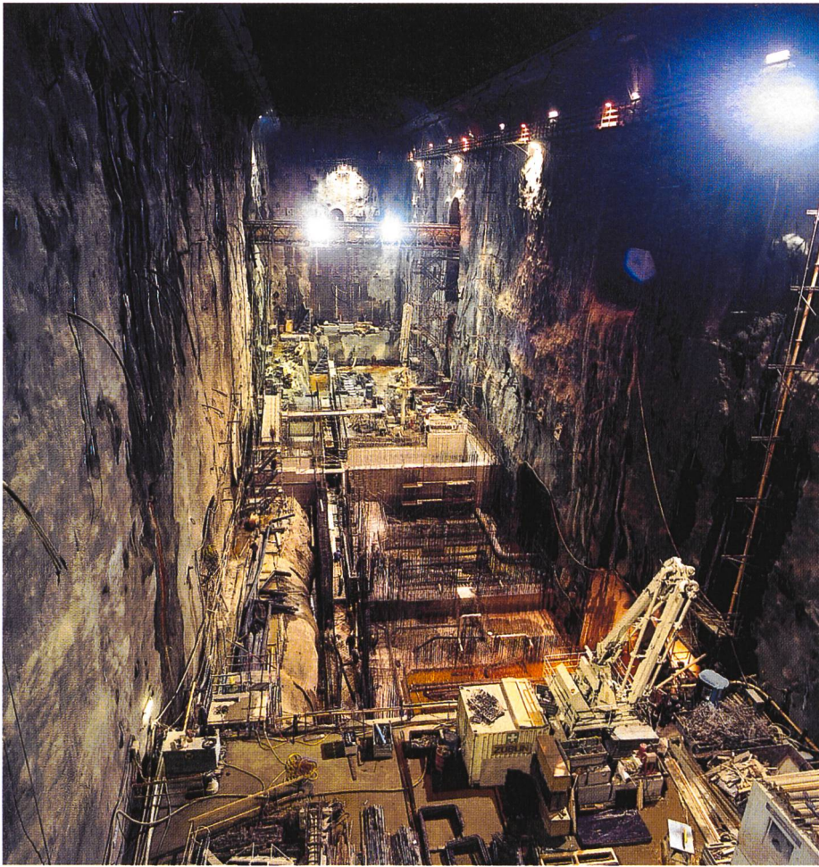
Bild 2. Blick in die grosse Maschinenkaverne des Pumpspeicher-Kraftwerks Goldisthal. (Werkfoto: Züblin)
