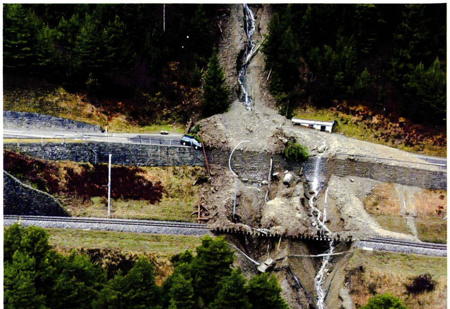
Bild 11. Bei Disentis wurden Kantonsstrasse und Bahnlinie durch einen Murgang stark beschädigt (Bildquelle: C. Wilhelm, Amt für Wald GR/A. Bischoff, Tiefbauamt GR).
