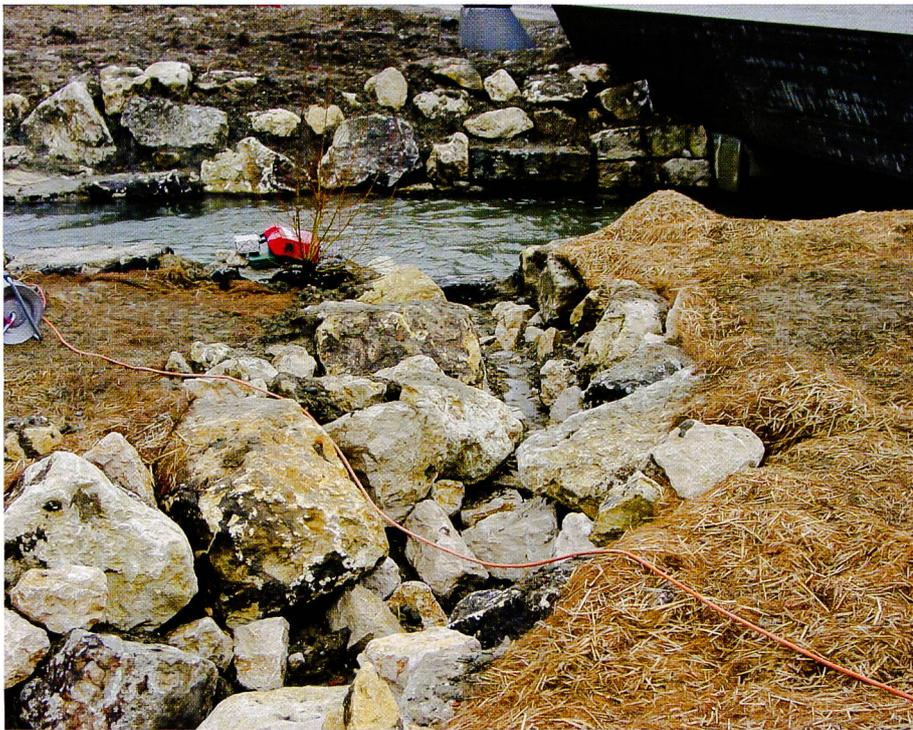
**Bild 6. Der oberwasserseitige Ausstieg der Fischtreppe.**
