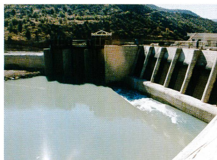
Bild 14. Spülkanal des Kiesabzugs vor dem Entsandereinlauf.
