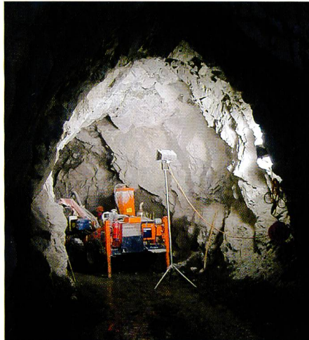
Bild 30. Ausbruchsarbeiten des Entsanders.
