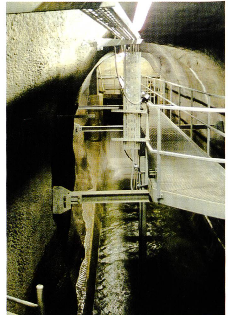
Bilder 3 und 4. Beispiele von zwei Entsanderkammern mit horizontaler Spülung.
