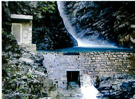
Bild 17. Festes Überfallwehr mit Spülschütze und Dotierauslass.
