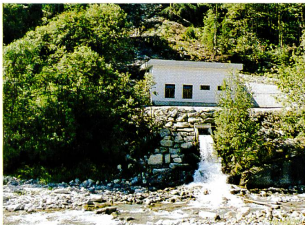
Bild 27. Auslauf des Umleitstollens, Bergstation Seilbahn, Zugang Entsander, Druckleitungsstrasse und Zentrale mit Wasserrückgabe.
