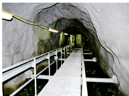
Bild 32. Entsanderkammer mit Bedienungsteg.
