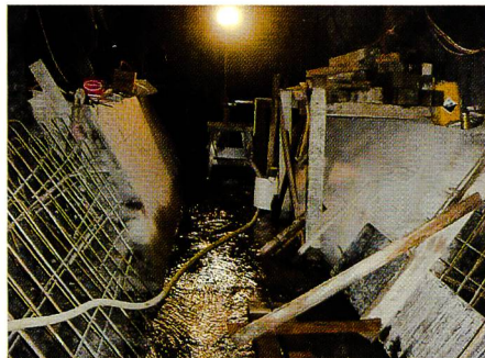
Bild 31. Spülkanal des Entsanders im Rohbau.
