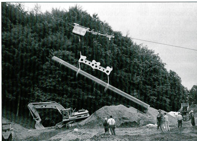
Transport und Versetzen Erdgasleitung, Rohrgewicht 12 Tonnen
