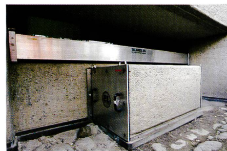
Bild 2. Lichtschacht und Fenster sicher geschützt mit Hochwasser-Schutzsystem Talimex.
