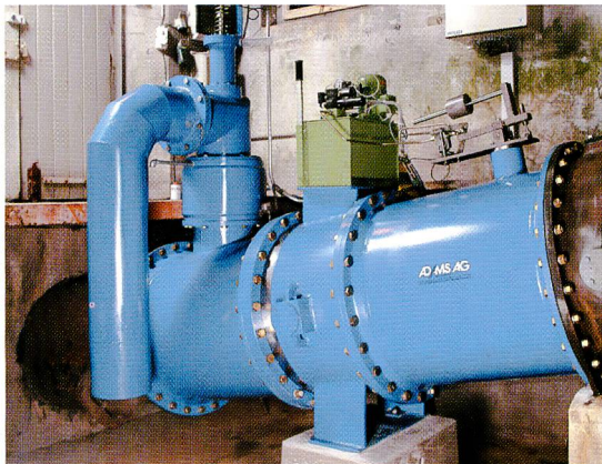
Rohrbruchsicherung Sicurezza rottura tubo Sécurité rupture de tuyau
