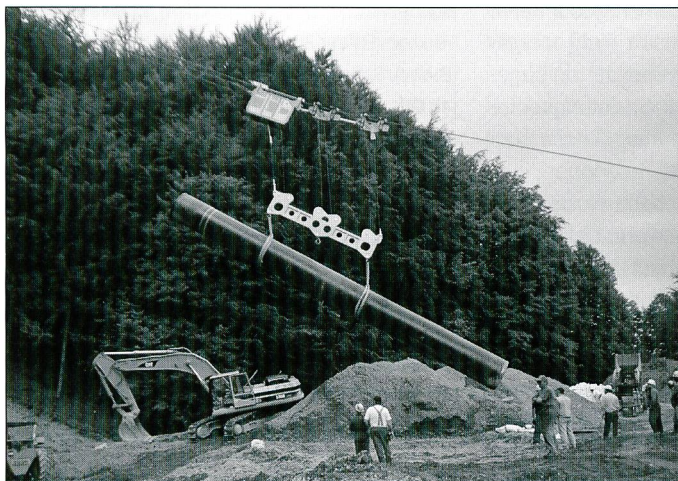
Transport und Versetzen Erdgasleitung, Rohrgewicht 12 Tonnen
