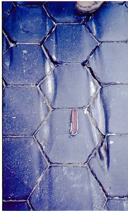
Bild 8. Linienförmige Abrasion in einem Gerinne mit Betonsohle (links) sowie abgeschliffener Schmelzbasalt (rechts).
