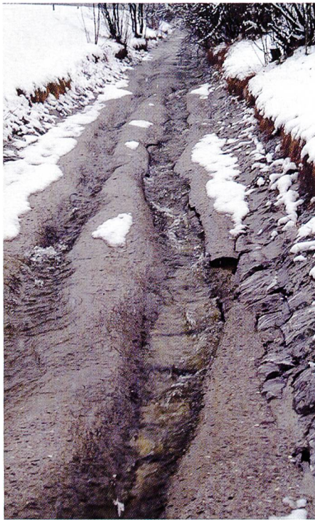
Bild 8. Linienförmige Abrasion in einem Gerinne mit Betonsohle (links) sowie abgeschliffener Schmelzbasalt (rechts).
