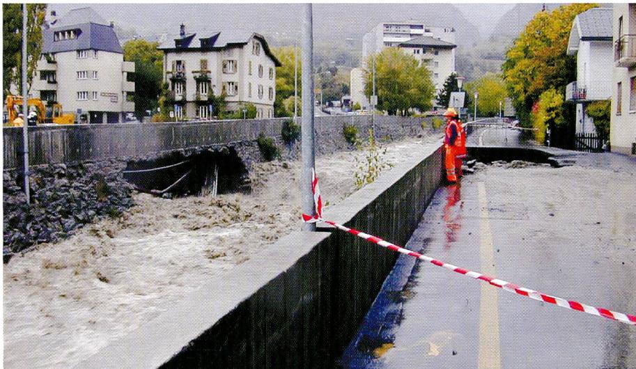
**Bild 15. Einbrüche der Ufermauer bei einer Sperre am 15. Oktober 2000 (Foto A. B.).**
