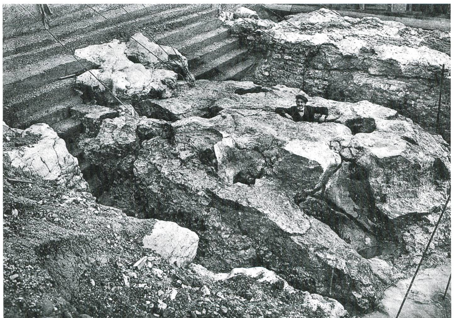
Bild 6. Felsenuntergrund des KW Gösgen während der Bauzeit.
