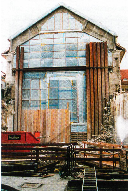
Bild 7. Abdichtungsmassnahmen beim KW Gösigen zum Schutze der in Betrieb stehenden Maschinen.
