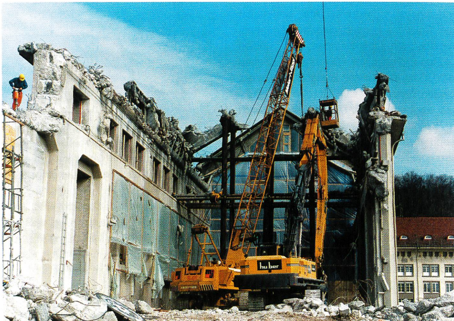
Bild 4. Abbrucharbeiten für den Umbau des KW Gösgen.
