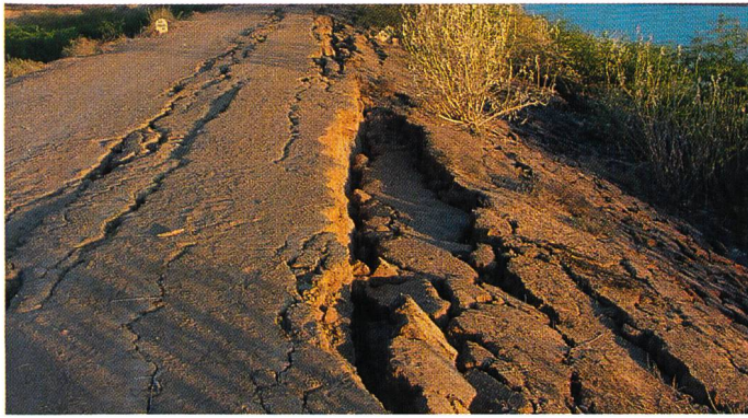
Bild 2. Erdbebenschäden an zwei Schüttdämmen (links: Shivilakha-Damm mit wasserseitiger Rutschung, rechts: massive Querrisse und Setzungen im Chang-Damm), die während des Bhuj-Erdbebens vom 26. Januar 2001 in Indien beschädigt wurden. Insgesamt mussten bei rund 245 Dämmen Reparatur- und Verstärkungsmassnahmen getroffen werden (Fotos: Prof. S. K. Jain und M. S. Patel).
