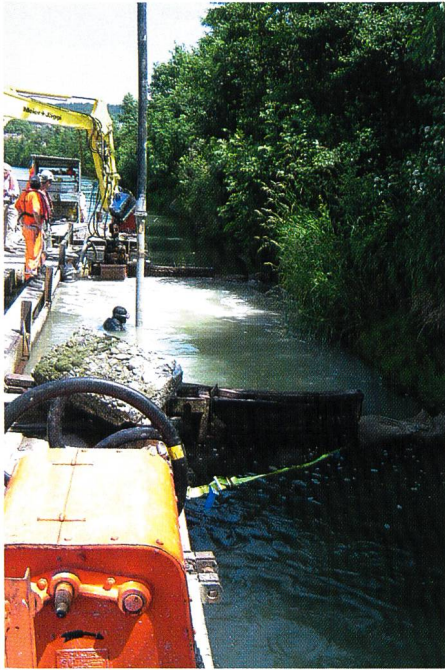
Bild 6. Unterwasserbetonierung mit Hilfe von Taucher in isoliertem Bereich zur Reduktion der Wasserverschmutzung.
