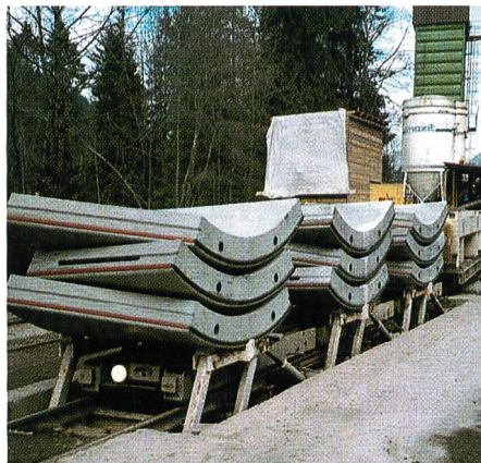
Bild 2. Zwischenlager für Stahlfaserbeton-Tübbing.
