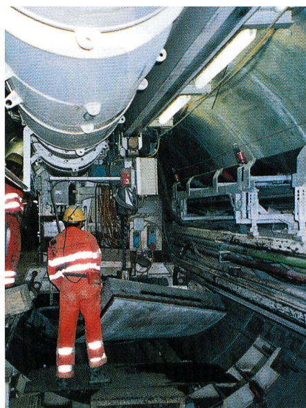
Bild 3. Einbau der Stahlfaserbeton-Tübbing für den einschaligen Ausbau des 5,2 km langen Transitgasstollens Sörenberg.
